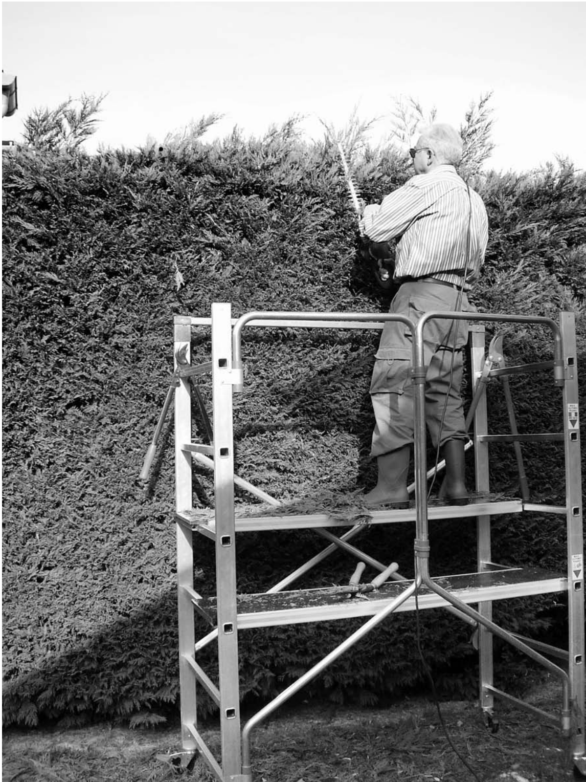
L'échafaudage est devenu indispensable pour entretenir la haie de faux cyprès. Il circule entre voisins (cliché de l'auteur, Bussy-Saint-Georges, 2005).
